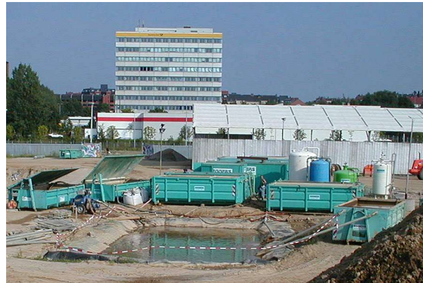
Absetzbecken, Kies- und Aktivkohlefilter
