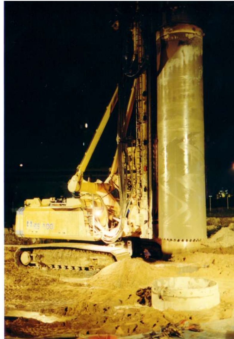
Bohrgerät bei Nacht, Ansatz einer weiteren Bohrung
