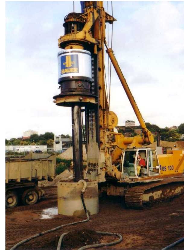
Großbohrgerät BG 36 beim Ausbohren der Verrohrung (Ø 2.000 mm) und Wasserzugabe
