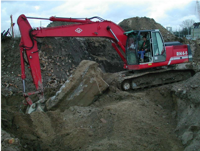
Bergung von Fundamentresten im Rahmen der Baufeldfreimachung
