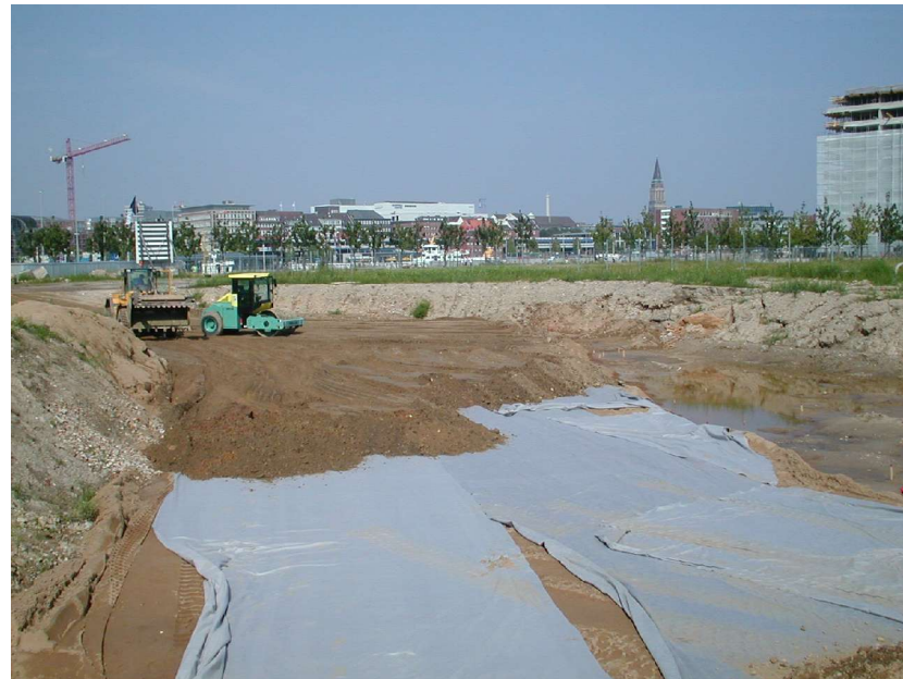
Herstellen der Bohrebene
